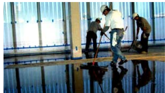
Hoàn thiện bề mặt sàn
