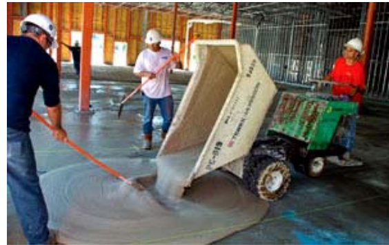
Thi công lớp phủ sàn bằng vữa tự san phẳng
